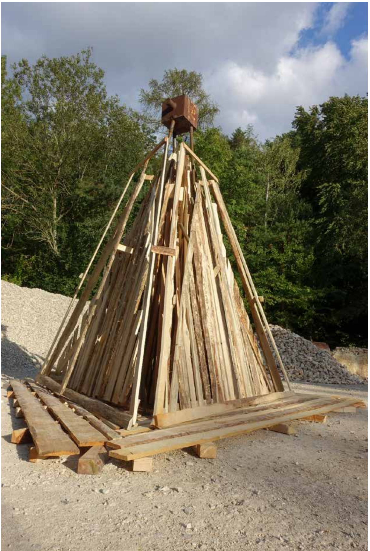
Aufbau der Holzkonstruktion
