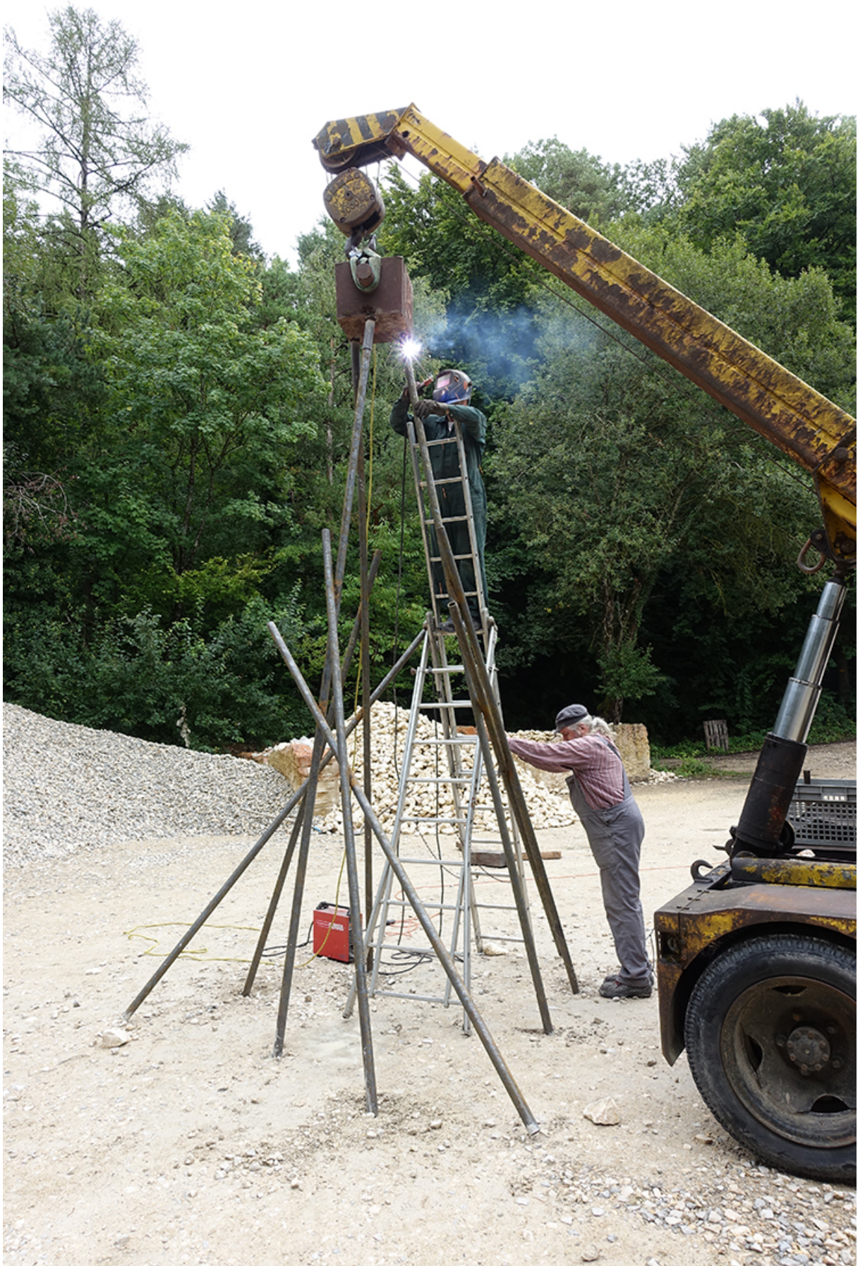
Aufbau der Eisenkonstruktion
