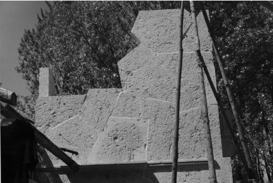
Polygonales Mauerwerk
