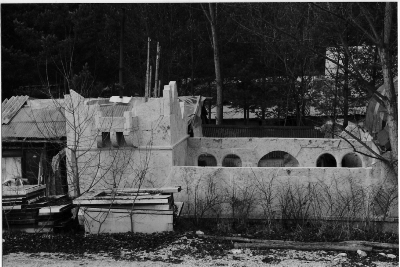
Im Bau. Um 1996
